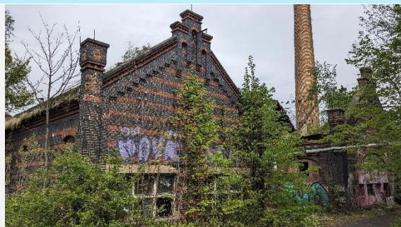
Sanierung/Erhalt der Zentralhallen
