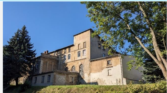
Potenzial Energieeffizienzmaßnahmen An der Weißen Mauer
