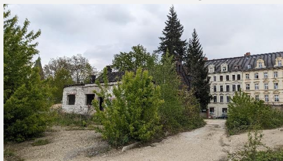
künftiger Eingangsbereich mit Pfortnerhäuschen
