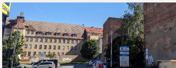
fehlende Durchwegung zum Handelshof
