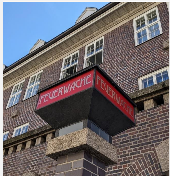
Historische Feuerwache Krölstraße 26
