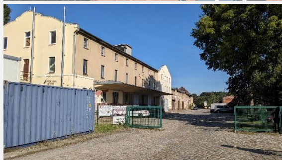
Industrie- und Gewerbebauten nördlich Rauschwalder Str.
