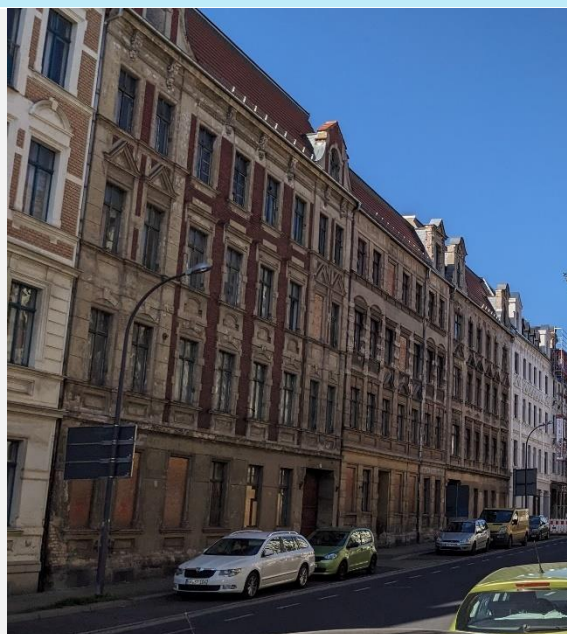
Bsp. Sanierungsschwerpunkt Brautwiesenstraße
