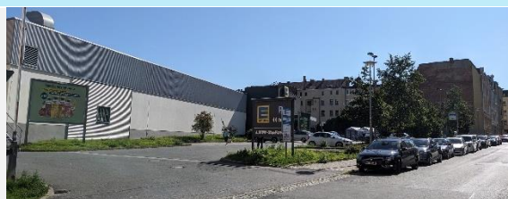
fehlende Raumkante Dresdner Straße
