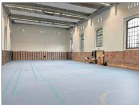
Ein Blick in die Turnhalle Cottbuser Straße während der Bauarbeiten.
