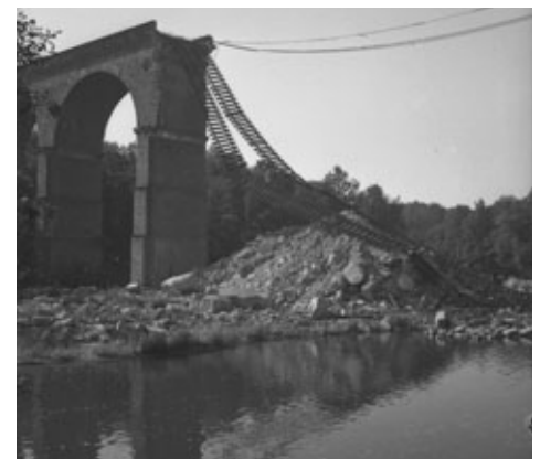
Zerstörter Neißeviadukt (Mai 1945)
