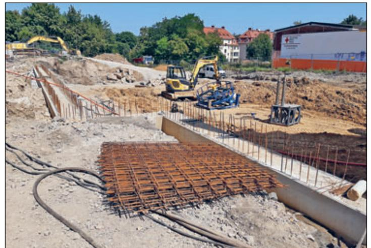
Blick von Süd-West auf die Baugrube Ost: Ab September 2025 beginnen hier die Rohbauarbeiten zunächst mit dem Untergeschoss des Neubaus. Außerdem sichtbar: der Kopfbalken der Bohrpfahlwand
