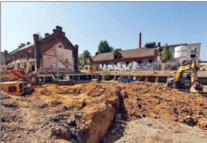
Blick von Nord-Ost auf die Bestandsgebäude: Beginn der Aushubarbeiten für Baugrube Ost und Spritzbetonausfachung der Bohrpfahlwände
