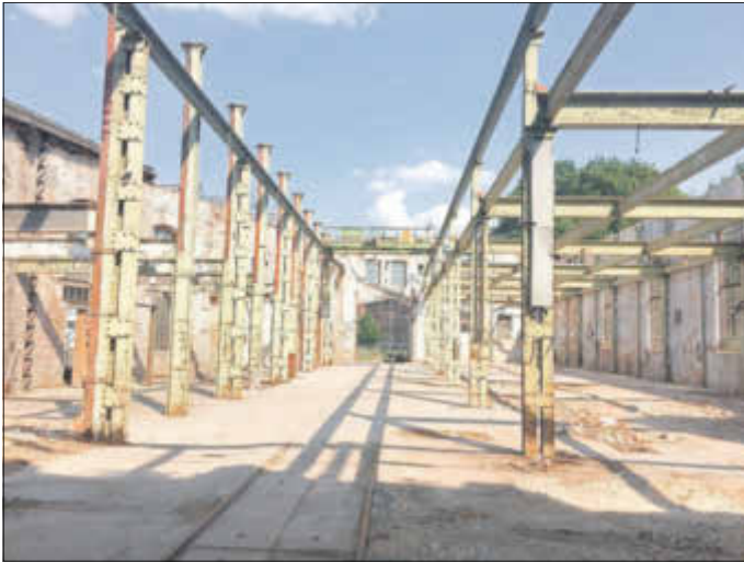
Blick in die ehemalige Furnierhalle
