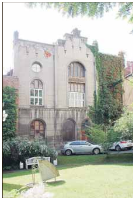
Alte Synagoge auf der Langenstraße
