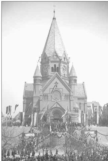
Von 1898 bis 1901 wurde sie als erster evangelischer Kirchenbau seit der Reformation in Görlitz erbaut. Der rote Backsteinbau mit kreuzförmigem Grundriss weist neoromanische Formen auf. Ohne beachtliche Schäden überstand der Zentralbau die beiden Weltkriege. Erst in den 1950er Jahren kamen Bauschäden zu Tage. Deren Behebung begann in den 1970-er Jahren. Nach
