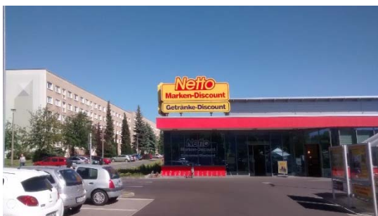
Foto 9: STZ Schlesische Straße, Netto-Markt
