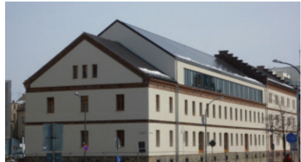
Landratsamt mit Photovoltaik-Anlage
