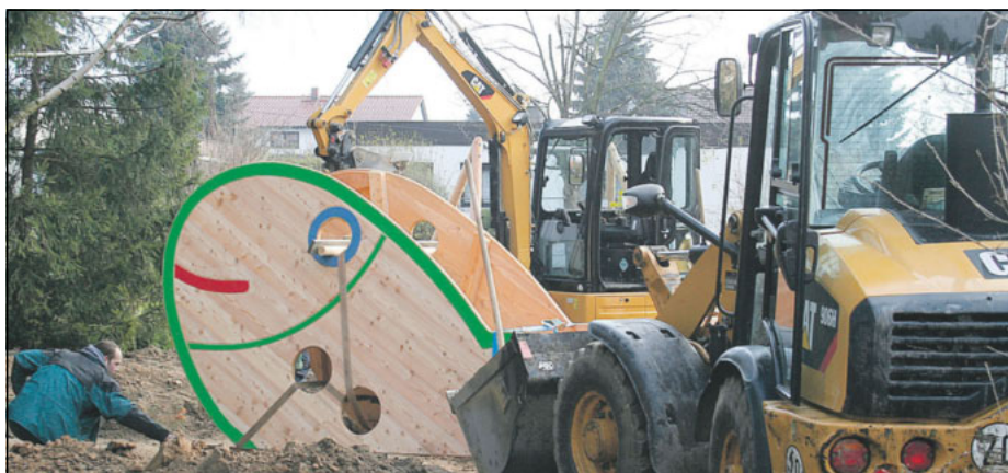
Zwischen Bagger und Radlader taucht plötzlich ein großer Fisch auf
