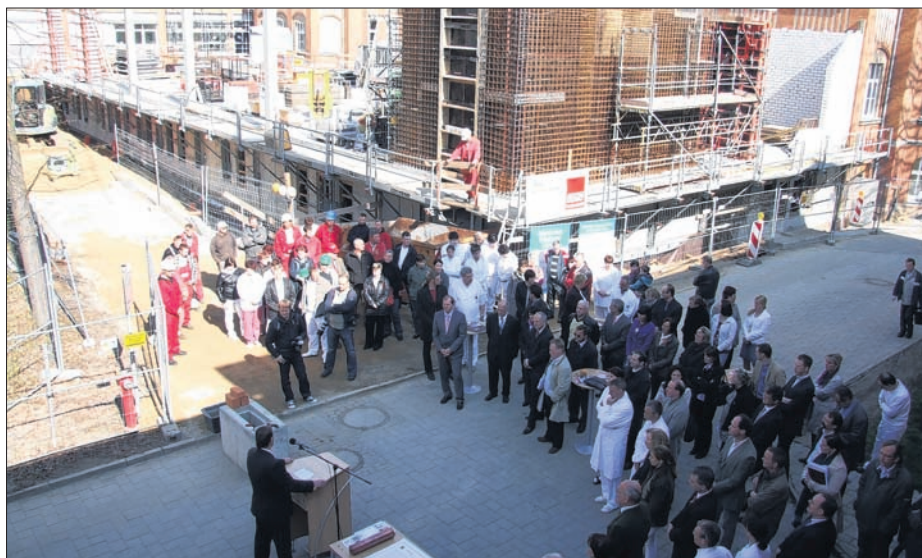
100 Gäste kamen zur Grundsteinlegung ins Städtische Klinikum Görlitz.
