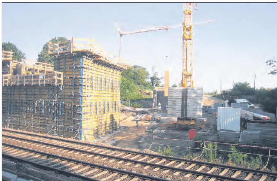
Schalungsbau südliches Widerlager BW 3 Foto: Planungsbüro Richter und Kaup, Görnitz
