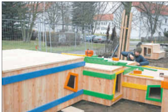
Im Dezember wurde noch gebaut und montiert, damit der Spielplatz in Hagenwerder vor Weihnachten fertig wird.
