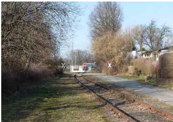
Gleisanlagen am Siebenbörner
