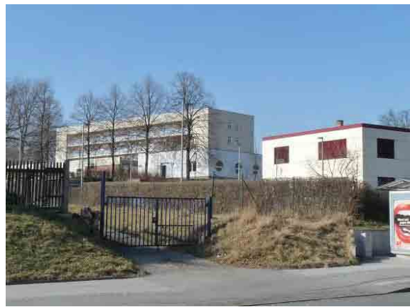
Blick von der Zeppelinstraße zum Gelände des Klinikums
