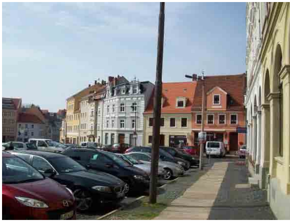
westl. Demianiplatz mit Sanierungsbedarf des Platzraumes
