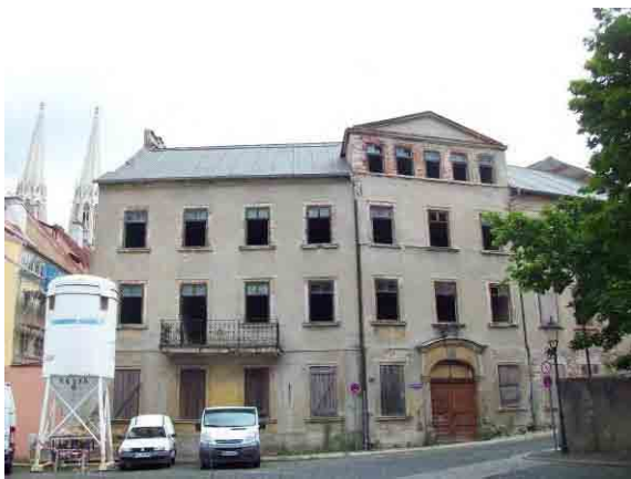
gesicherte Bausubstanz, Judenstraße 11(2016 Sanierung)
