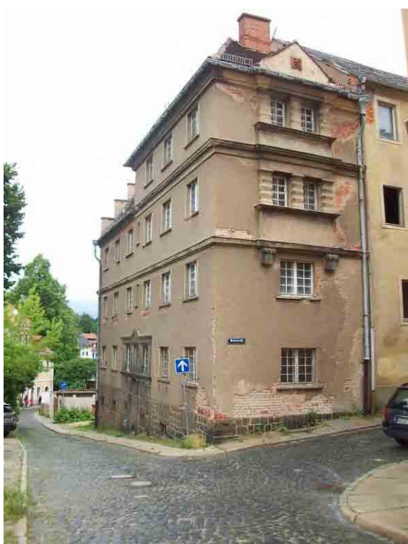
Helle Gasse und Rosenstraße, Gebäude mit teils dringendem Sanierungsbedarf
