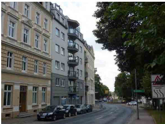
Lückenschluss Biesnitzer Straße (Südstadt)
