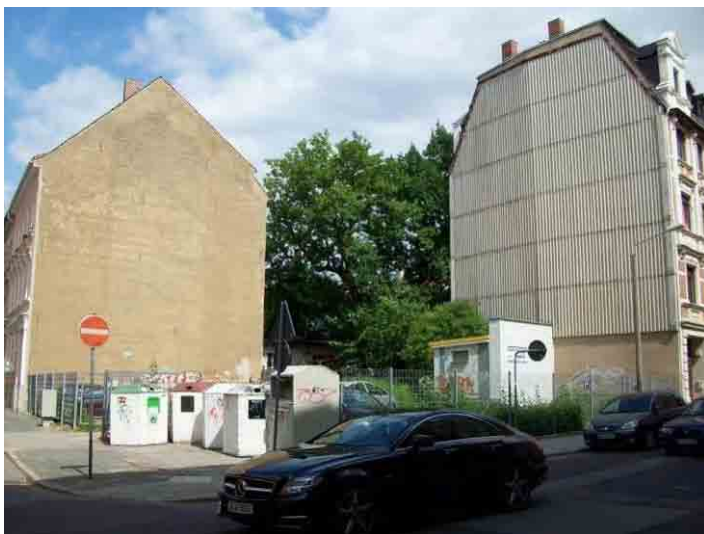
Hartmannstraße, Ecke Hospitalstraße, Baulücke
