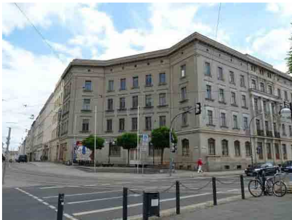
Ecke Bahnhofstraße/Berliner Straße, leer stehendes Hotel
