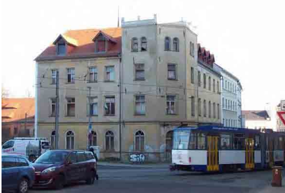
Heilige-Grab-Straße, unsanierte, gesichertes Eckhaus
