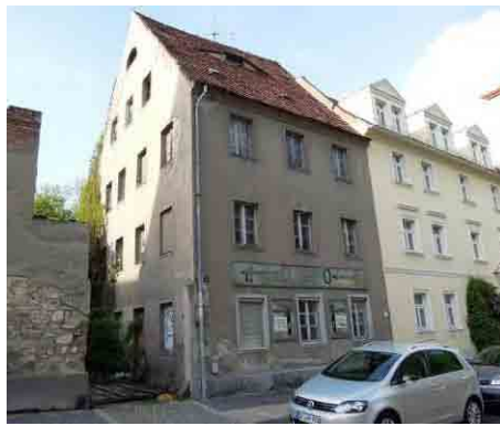
Jakob-Böhme-Straße 4, Vorder- und Hofansicht
