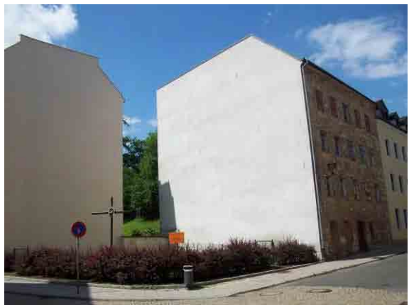
Baulücke im Einmündungsbereich Schanze
