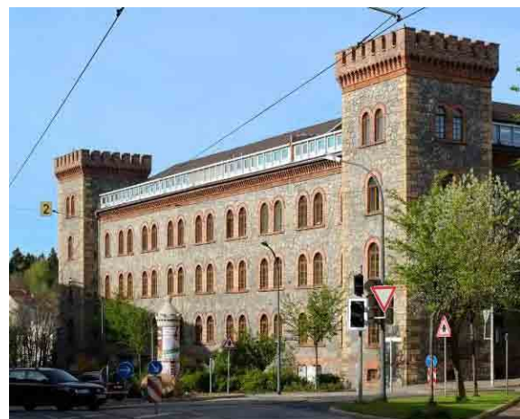
Umbau und Änderungen im Dachbereich, Verwaltungsstandort Hugo-Keller-Straße
