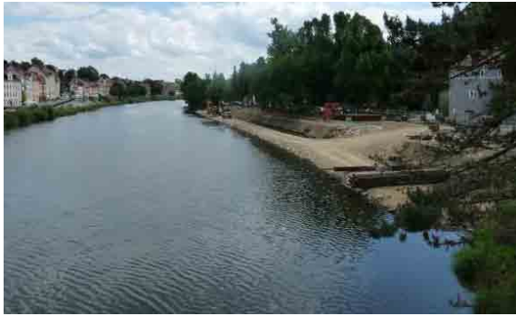
Sanierung des Uferbereichs an der Altstadtbrücke
