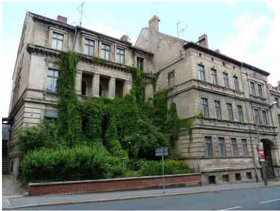
unsanierte Bausubstanz James-von-Moltke-Straße 29/30
