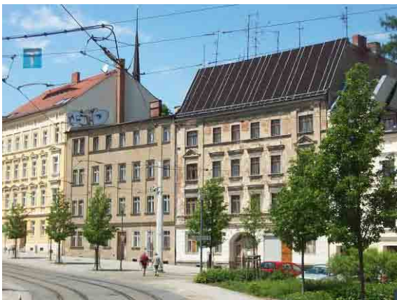
Heilige-Grab-Straße mit teils unsanierten Gebäuden
