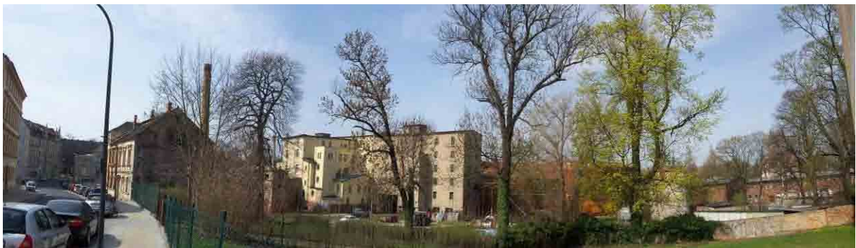
ehem. Hefefabrik, Blick von der Bautzener Straße
