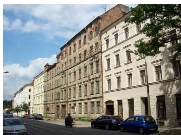
Grüner Graben 26/27, Sanierungsbedarf
