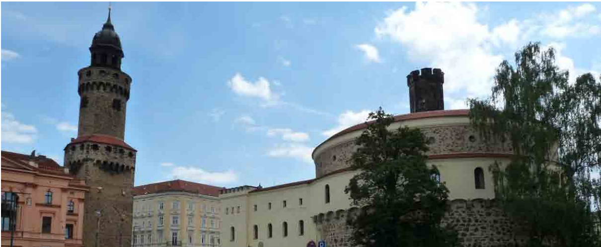
Kaisertrutz, Görlitzer Sammlungen für Geschichte und Kultur am Demianiplatz, grundlegende Sanierung und Renovierung im Vorfeld der 3. Sächsischen Landesausstellung 2011
