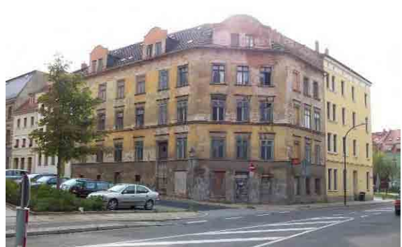
Hugo-Keller-Straße/Ecke Breite Straße, Sanierungsbedarf
