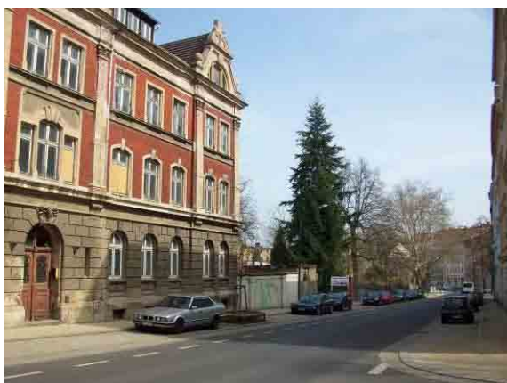
Bereich Rauschwalder Straße/Löbauer Straße/Hilgerstraße
