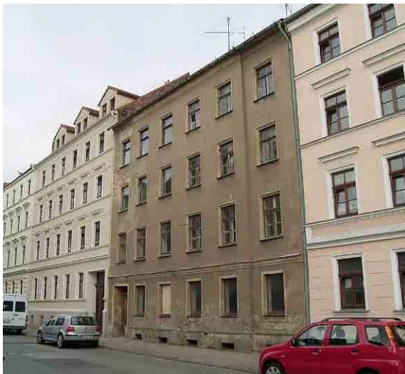
Sanierung und Umnutzung eines durch Grundbruch in seiner Standsicherheit gefährdet gewesenen Altbaus in der Pomologischen Gartenstraße mit Fenstervergrößerung (Bsp. war kein Denkmal)
