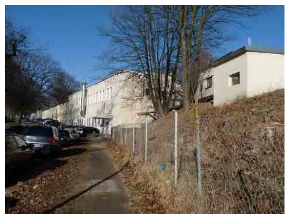
Gebäude des Waggonbaus an der Christoph-Lüders-Straße
