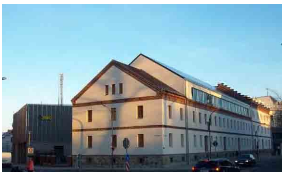
Energie-Effizienz-Quartier Landratsamt Bahnhofstraße
