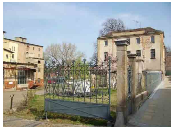
ehem. Hefefabrik, Einfahrt an der Bautzener Straße
